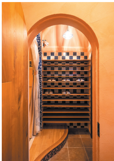
下駄箱の背面は、藍と白のタイルを市松模様に。 アーチ開口側面は、ガウディ建築にみるような 破砕タイル。玄関框の蹴込部分には 3色のモザイクタイル。
